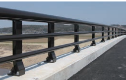
高欄・防護柵
